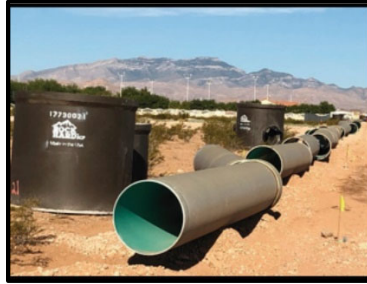
Fig. #2: 96" ID Manholes
